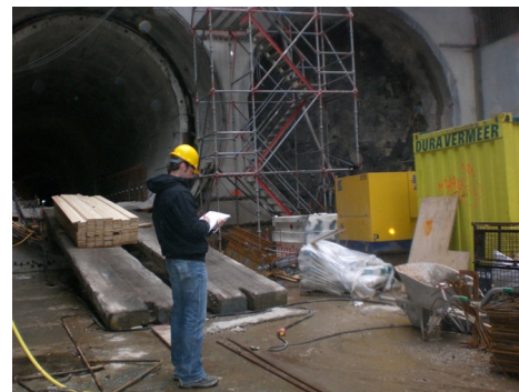
Figuur 4: Bas in actie bij boortunnel in Rotterdam
